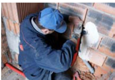
Monter sieci, instalacji i urządzeń sanitarnych
